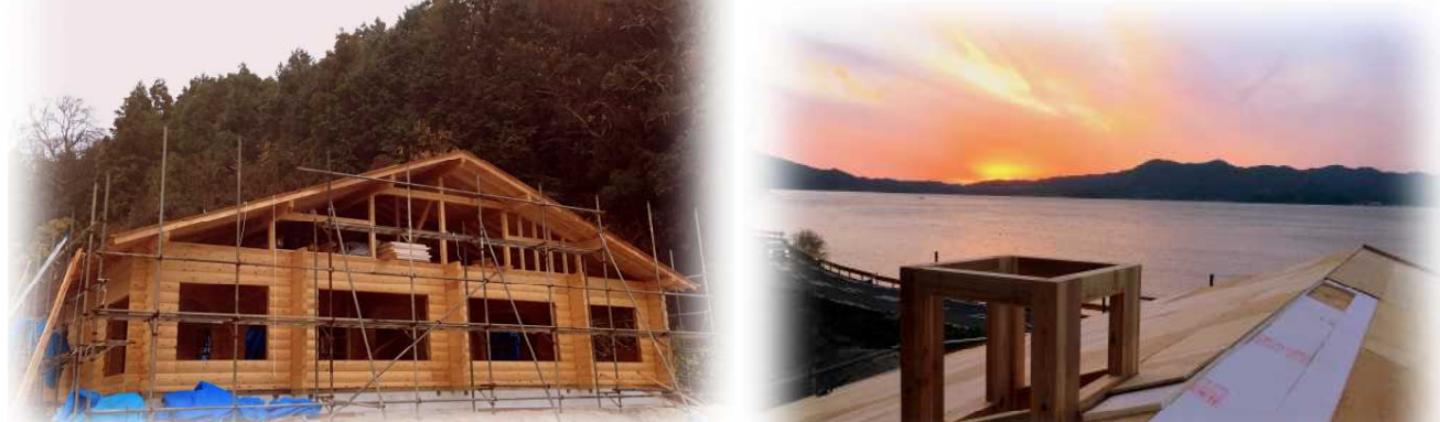
屋根下地工事終わる (12月26日 撮影：岡部 充)
